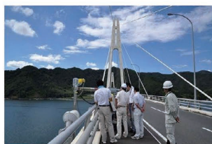
歩道付き橋梁は歩道部からの点検で車線規制が不要
