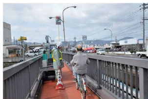
単独歩道橋や近接歩道橋は歩道橋からの点検で車線規制が不要
