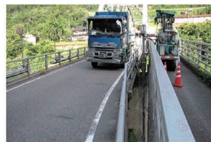
単独歩道橋や近接歩道橋は歩道橋からの点検で車線規制が不要
