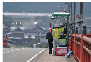
歩道付き橋梁は歩道部からの点検で車線規制が不要
